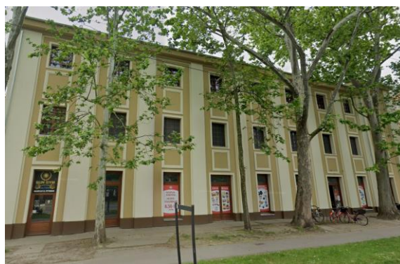
Felújított ipari épület a Fő utcában
